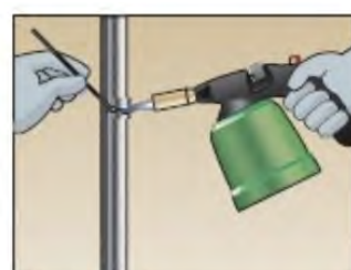
Solda de tubulação
